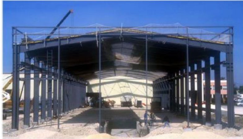
Figures 4 et 5: Portiques courants en profilés reconstitués soudés
