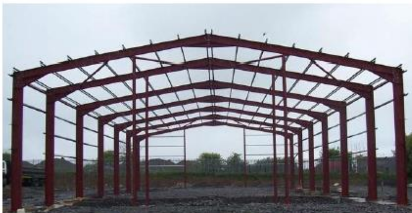
Figure 3 : Portique courant en profilés laminés à chaud
