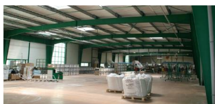
Figure 2 : Portique courant en profilés reconstitués soudés
