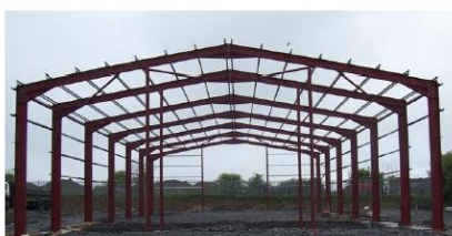
Figure 1 : Portique courant en profilés laminés à chaud
